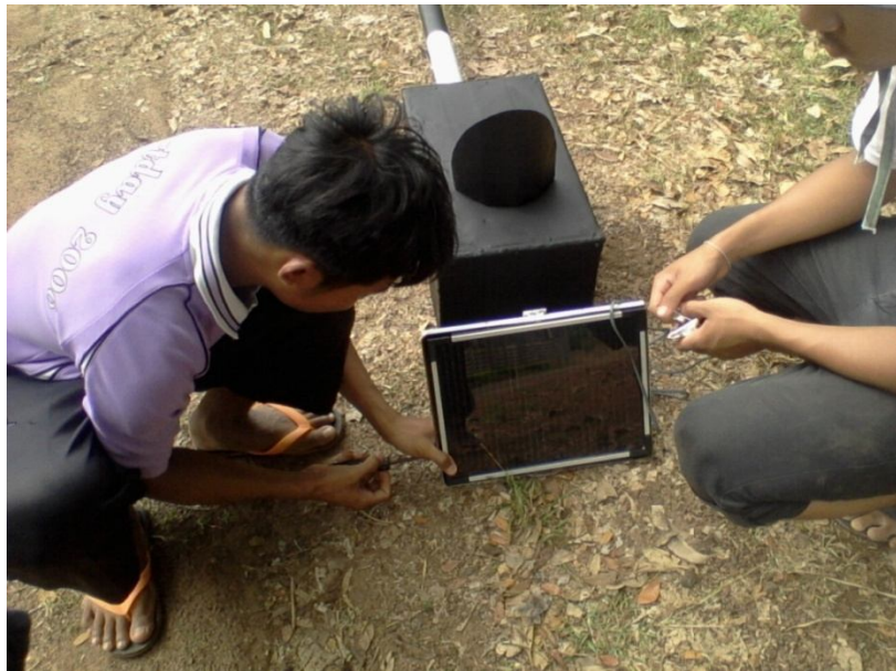
รูปที่ 3.2.9 ขั้นตอนการติดตั้งแผงโซลาร์เซลล์
