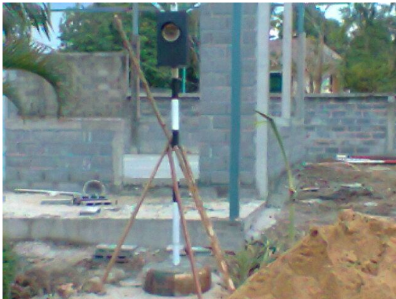
รูปที่ 3.2.8 ขั้นตอนการเทปูนฝังเสา
