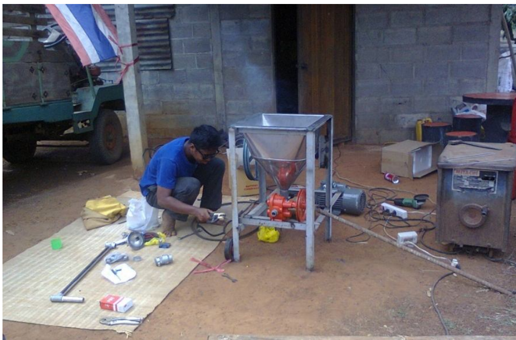
ภาพ ก - 9 การวางเหล็กที่ยึดปั๊ม
