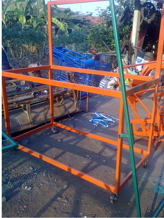
ภาพ ก-3 ทำสีโครงและติดล้อ
